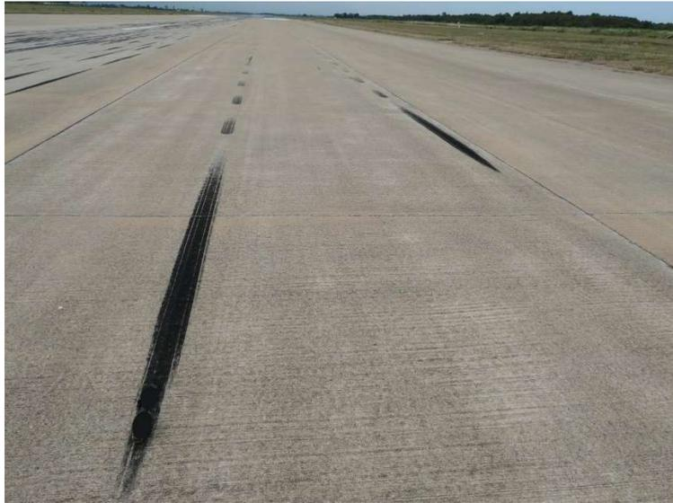
Figure 3 : traces du poser de l'équipier, Rafale M35
