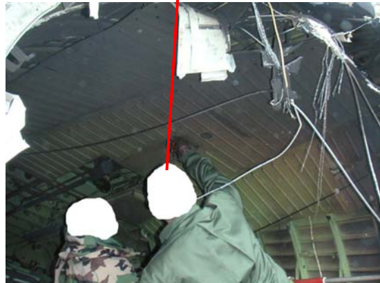
Opérations pour accéder au CVR
