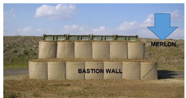
Photo 1 : bastion wall et merlon
