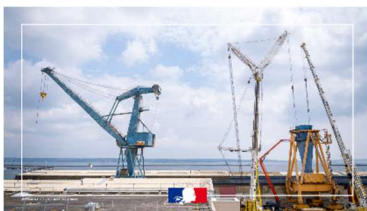
Grues en cours de démontage
