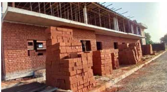
Bâtiment pour cadres célibataires sur le site de Rufisque, 80 places. Plan ministériel Hébergement. Construction en ossature béton et remplissage en briques de terre compressée réalisées sur site. Basse consommation énergétique. Montant : 3 M€
