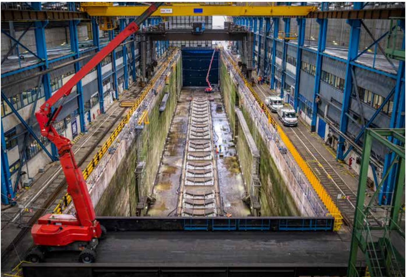
Opération majeure dans le bassin Nord de la base opérationnelle de l’île Longue qui a regroupé les travaux de maintenance (carénage des portes de bassin, rénovation du portique de l’atelier nucléaire mobile) et l’installation de nouveaux équipements (couverture du bassin, ligne de tins, porte tympan guillotine, pont roulant, potences de servitudes) essentiels au maintien en condition opérationnelle des SNLE.
