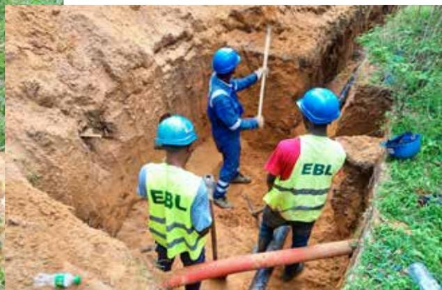
Réalisation de la pose d'un nouveau réseau d'eau, avec la mise en place d'une unité de traitement de l'eau (UTE) ce qui assure la potabilité de l'eau du camp De Gaulle.
